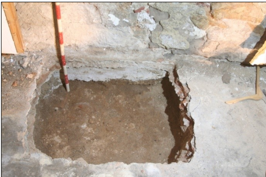
F4. Fotografia del Sondeig 3 un cop retirat el paviment UE 01
