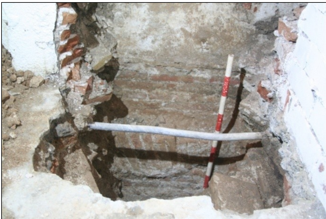
F8.- Fotografia de detall de la fonamentació UE 38.
